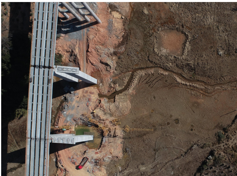
谢屋坑大桥桥墩周围布设临时排水沟（涵）
