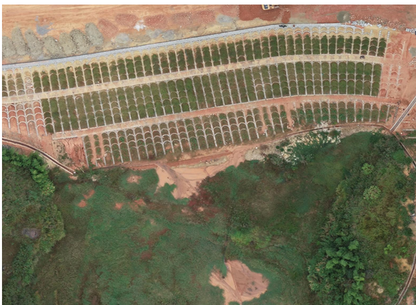
永定土楼互通塌陷区回填边坡治理
