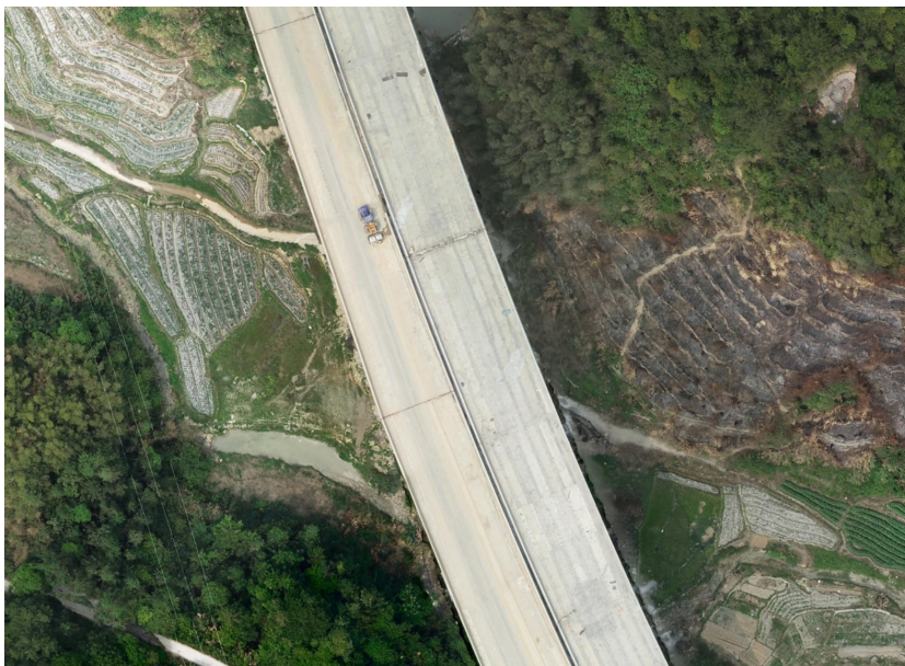
曾坑大桥桥下施工便道植被恢复绿化
