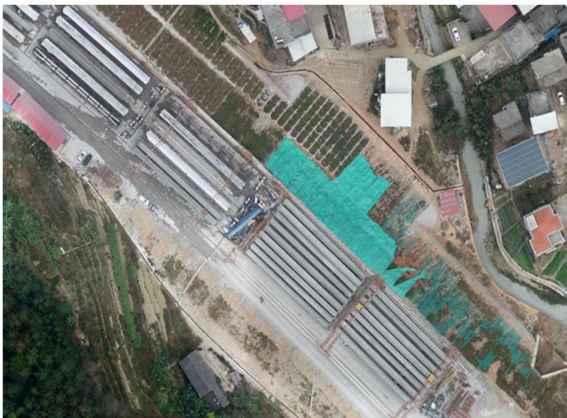
K27+500处路基填方边坡截排水与护坡
