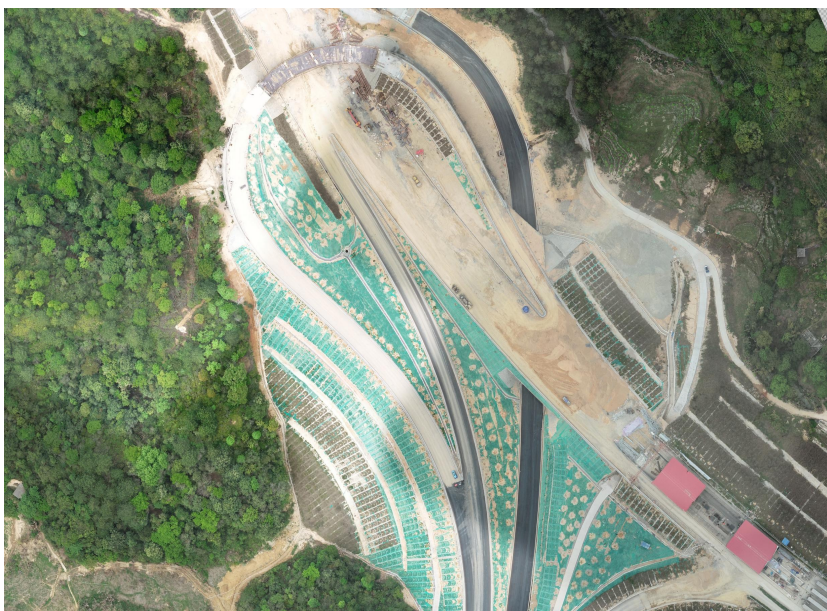
龙门互通匝道临时防护措施
