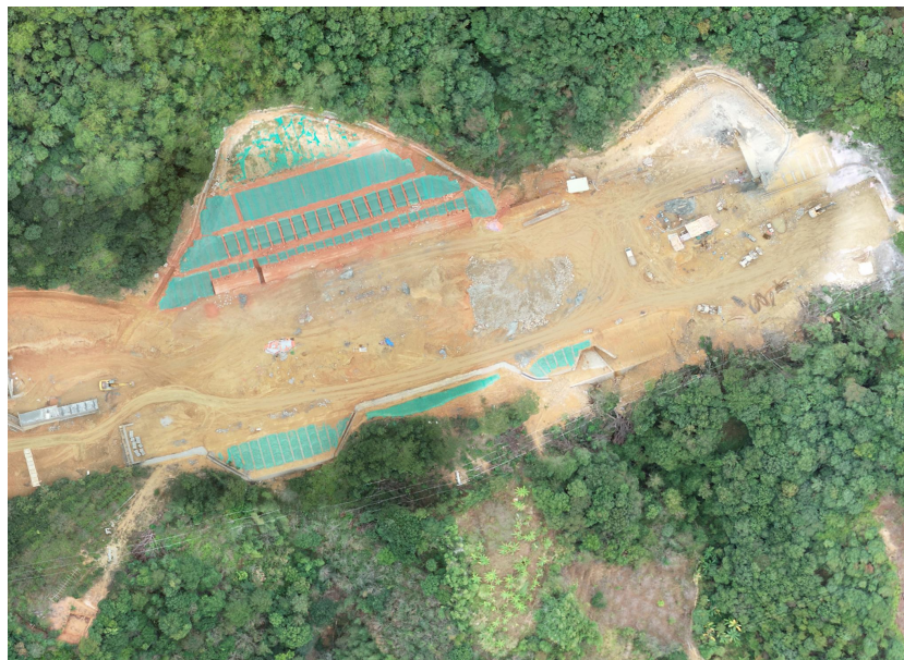
K13+350处路堑开挖山体边坡分级护坡绿化
