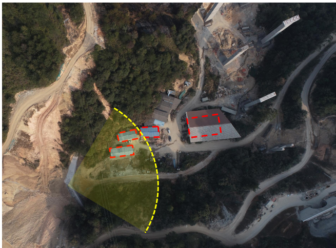
2021年1月19日项目建设阶段拍摄照片
