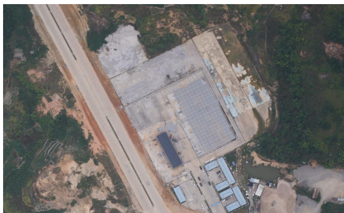
A2标段拌合站施工临时设施区拆除临建
