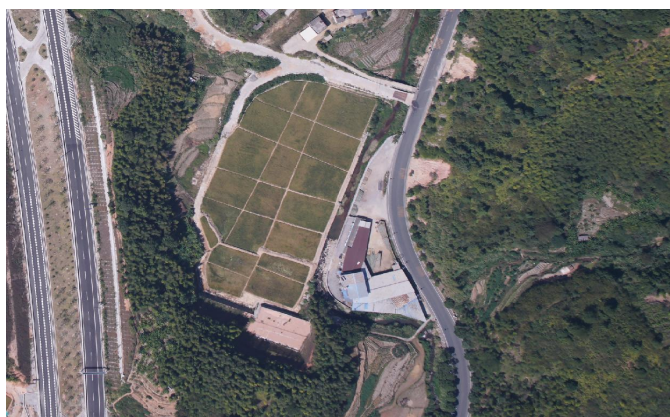
A3标段拌合站施工临时设施区土地复垦
