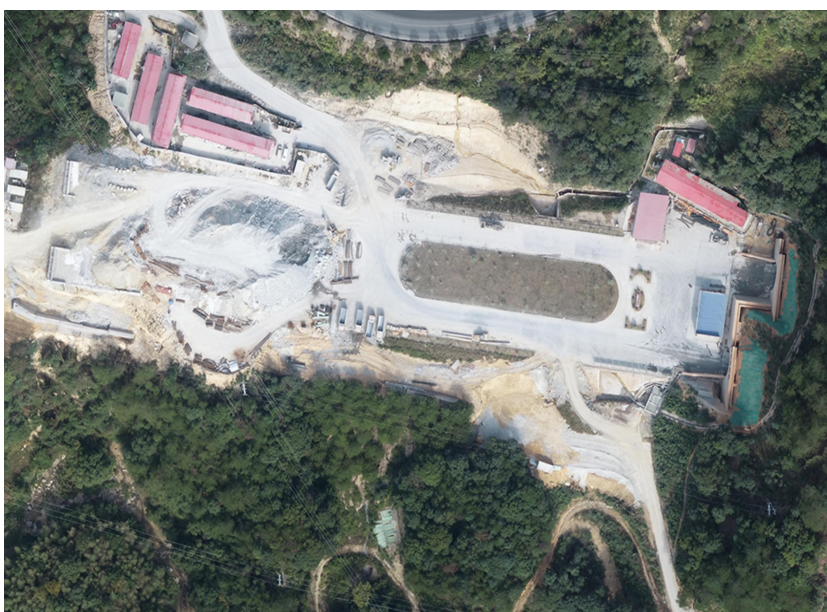
棋盘石隧道出口施工场地永临结合布设临时排水、拦挡和沉淀池等临时防护措施
