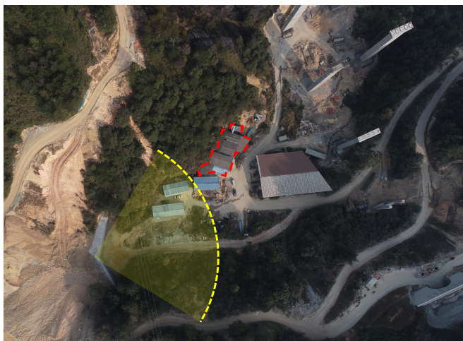
2021年1月19日项目建设阶段拍摄照片
