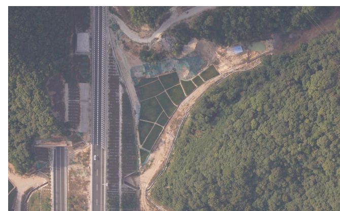
A3标段石渣中转场土地复垦
