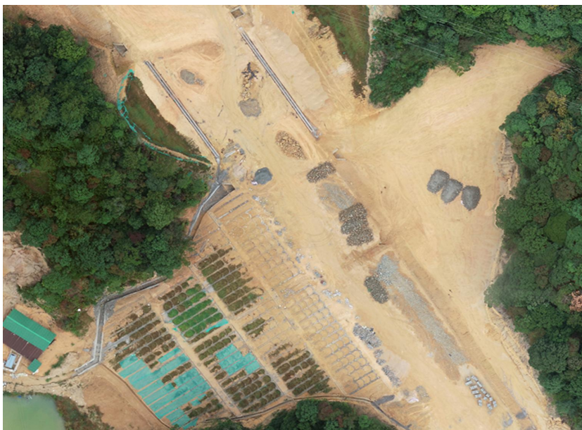
K21+000处路基填方边坡截排水与护坡
